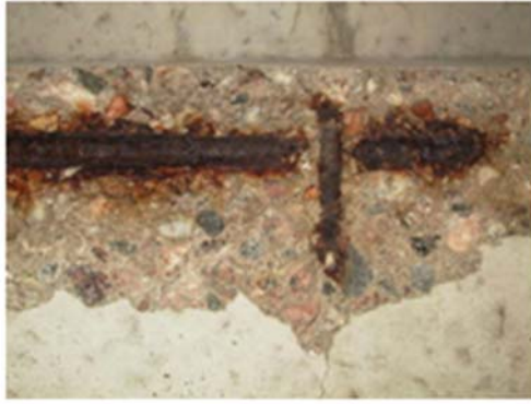
Exempel på skadad balkong. OBS! Annat objekt!
